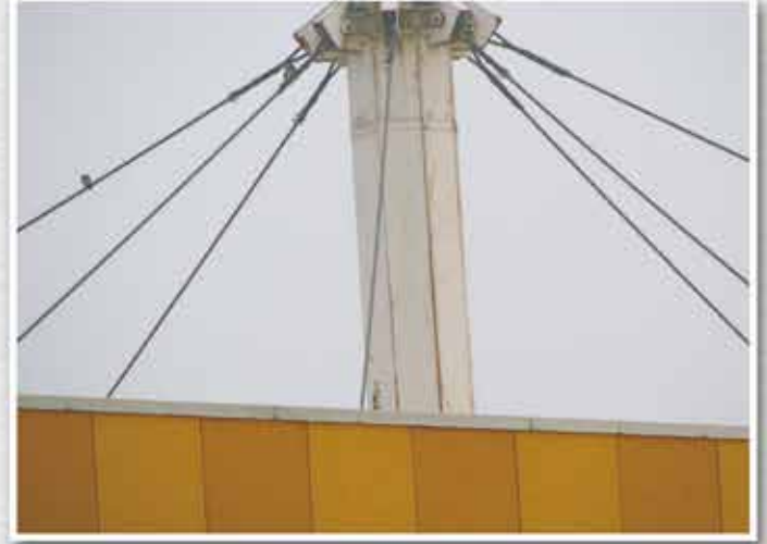
KONYA TÜYAP FUAR ALANININ 45 mm. ÖRGÜLÜ ÇELİK HALAT SAPAN SİSTEMLERİ
